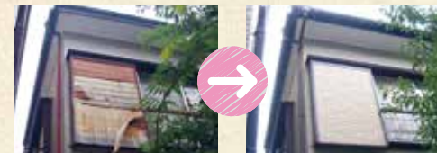
木製の戸袋がボロボロに… サイディングという外壁材に張替えました。
